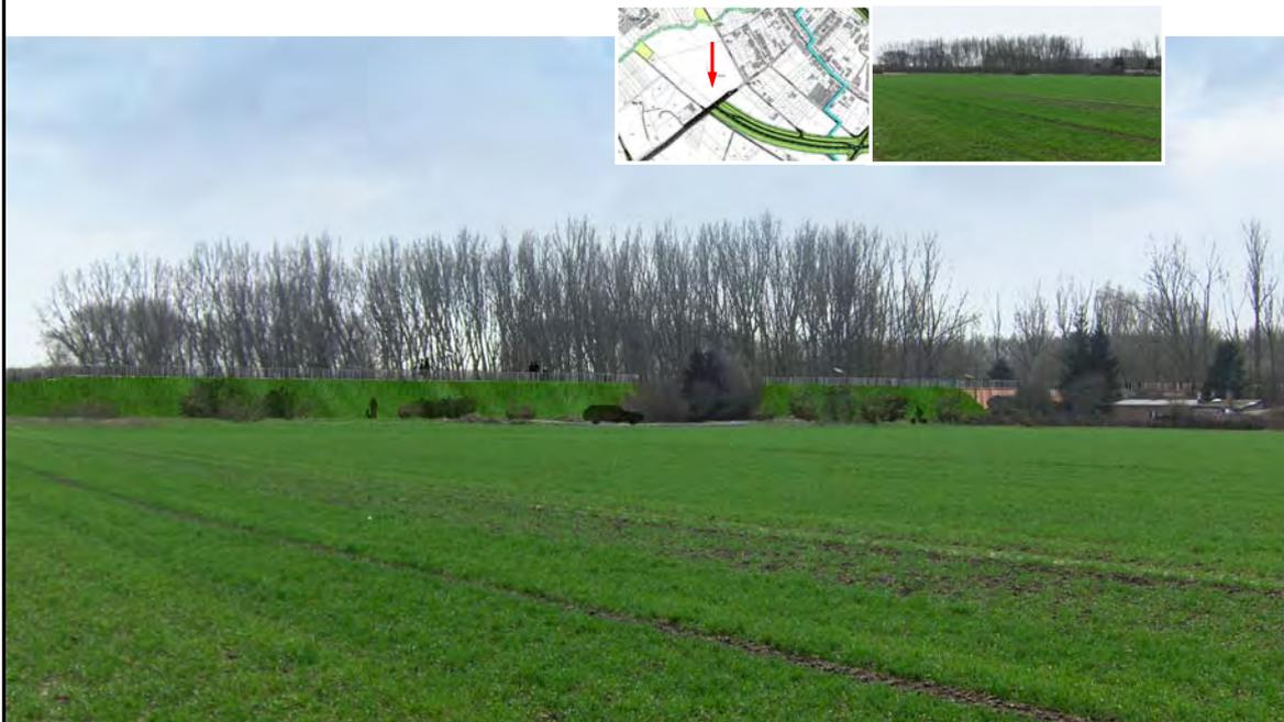
Blick vom Schmalen Wall (etwa Querung Pletschbach) – Spundwand Fangedamm mit Maßnahmen zu Einbindung ins Umfeld – Andeckung mit Boden und Begrünung (beidseitig und Bepflanzung)
